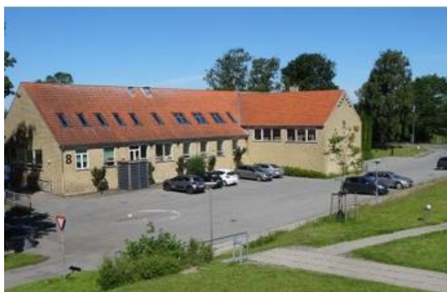
Alsønderup skole - skolebygning som skal restaureres
